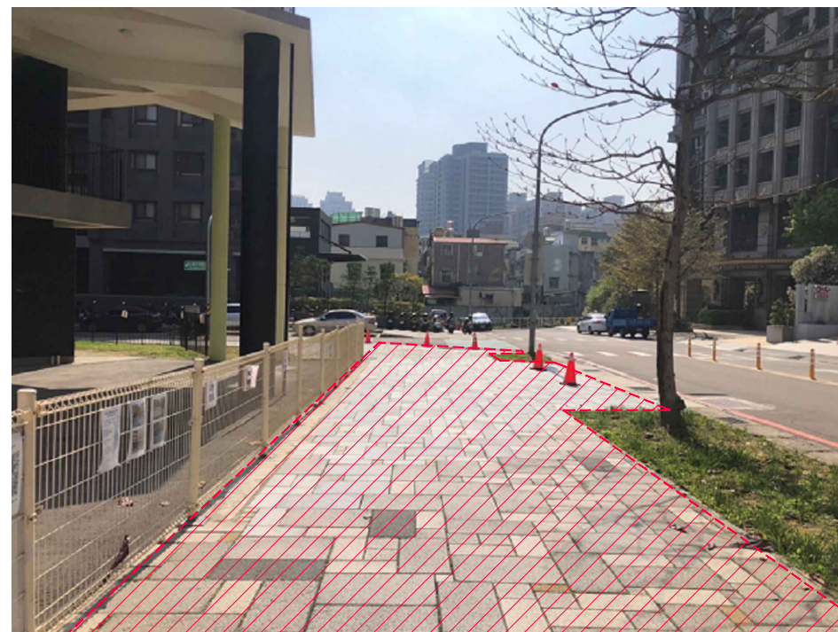
既有鋪面拆除及運棄
