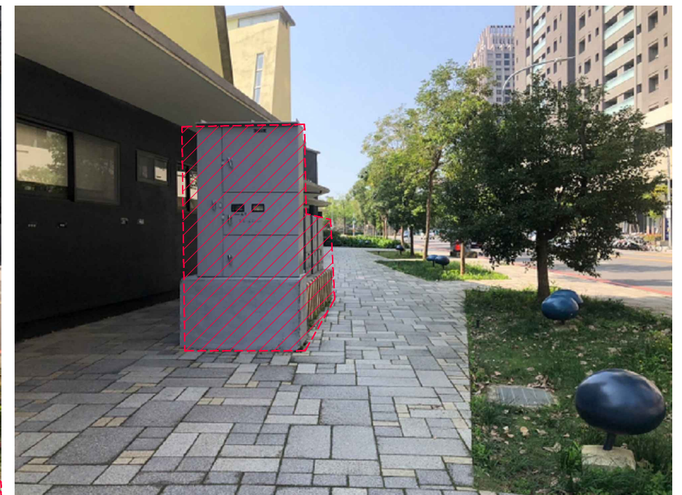
既有電箱移設(屬台電工程)
