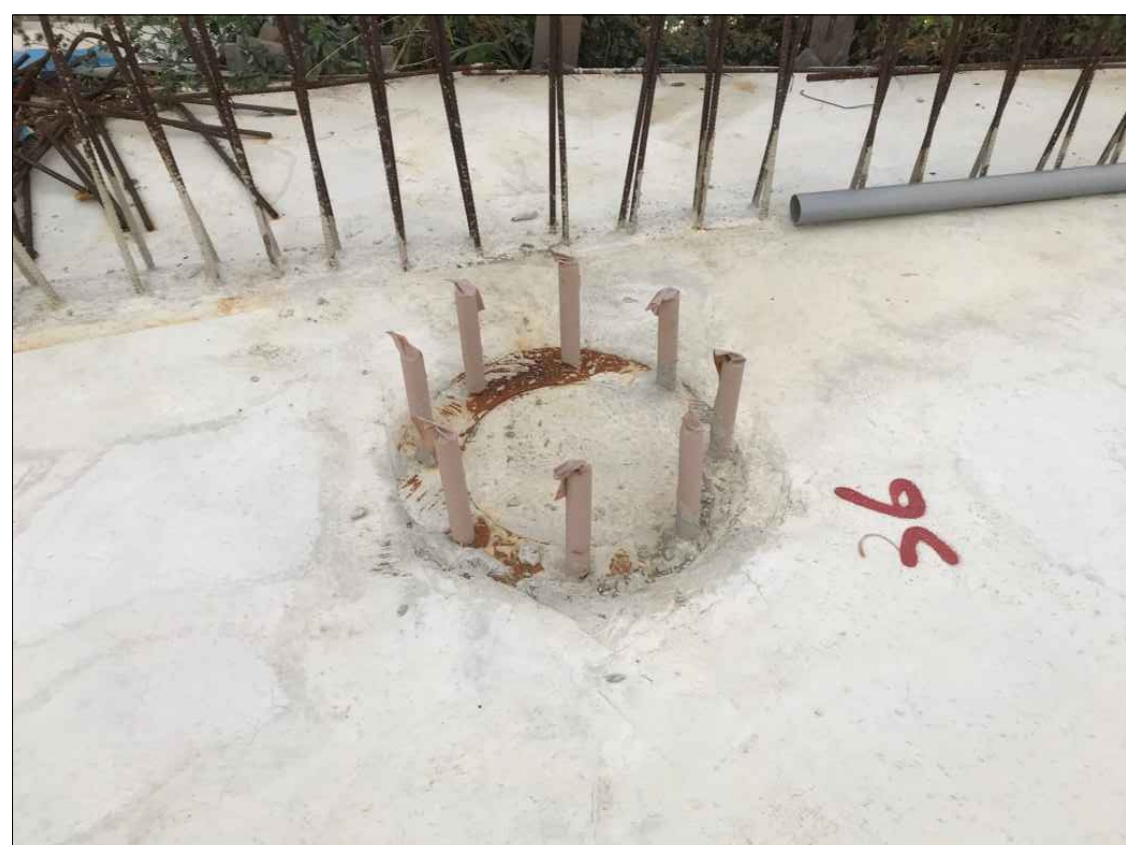
二期工程先行施作 H棟之1F板及鋼構預埋螺栓
