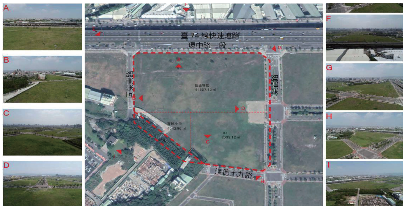
圖 1- 1 臺中市巨蛋體育館興建工程基地位置
