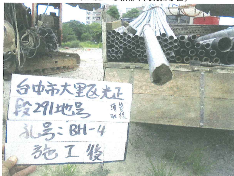
BH-4 孔 施工後照片(取樣薄管)
