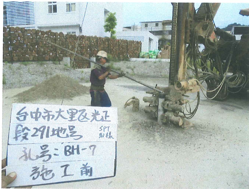
BH-7 孔 施工中照片(取樣劈管)
