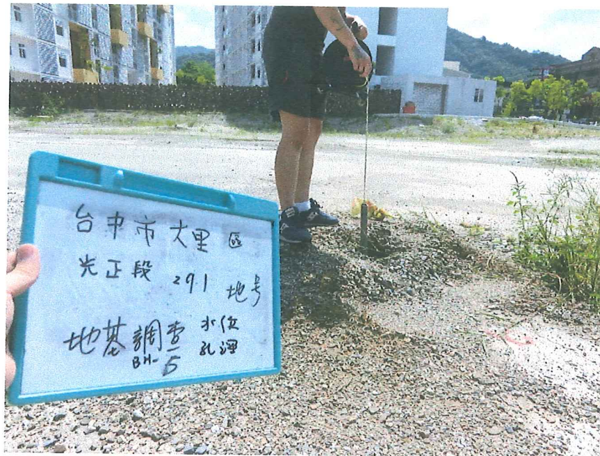
BH-6 孔地下水位觀測井照片
