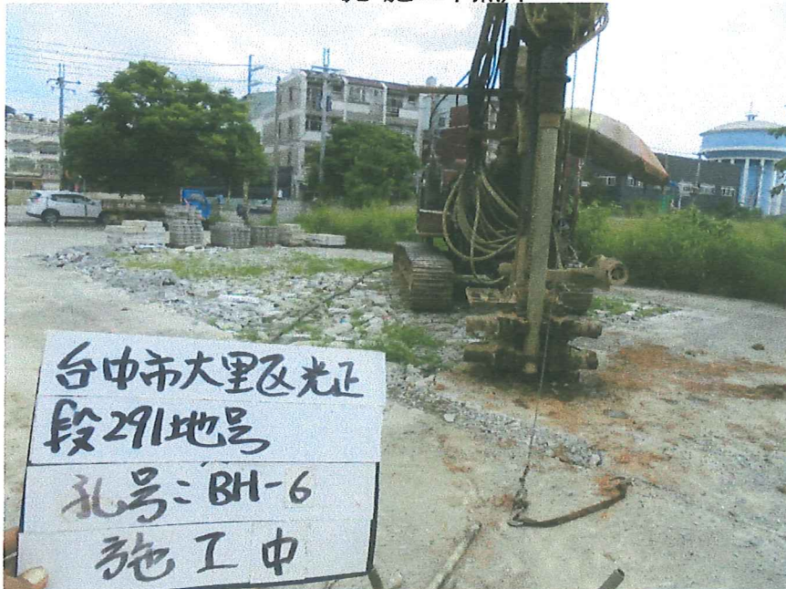
BH-6 孔 施工中照片
