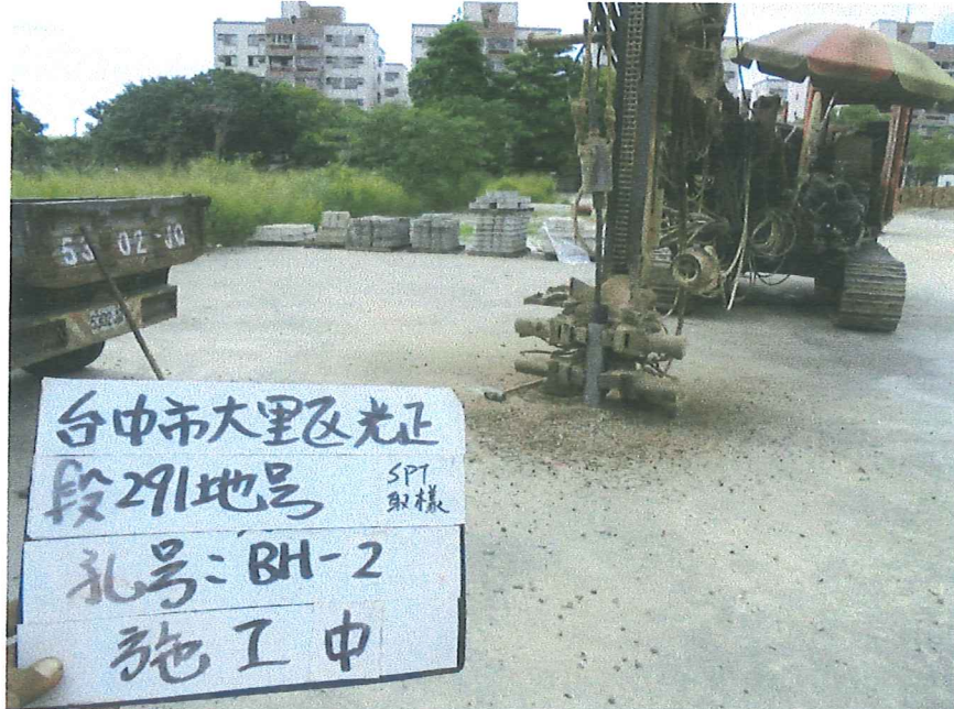
BH-2 孔 施工中照片(取樣劈管)
