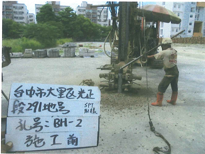
BH-2 孔 施工前照片(取樣劈管)
