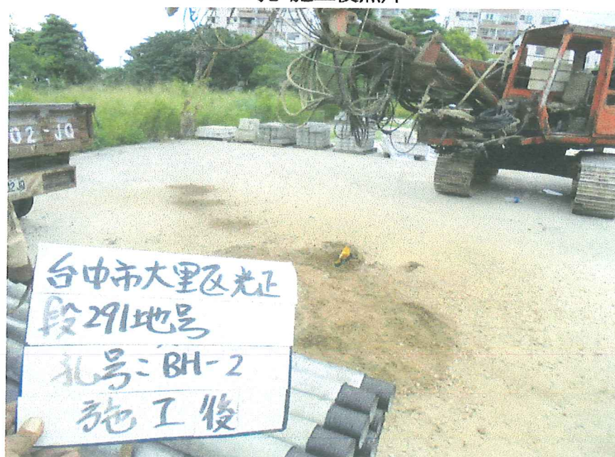
BH-2 孔 施工後照片
