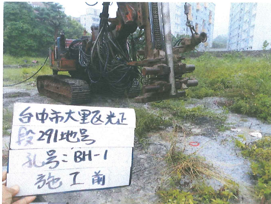
BH-1 孔 施工中照片
