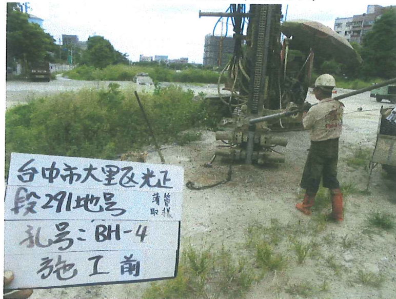
BH-4 孔 施工中照片(取樣薄管)
