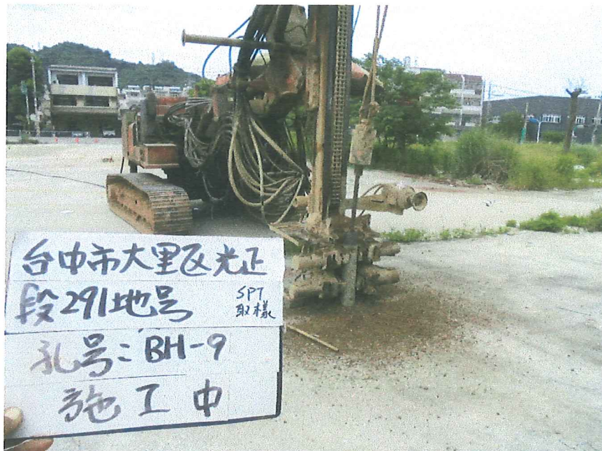
BH-9 孔 施工後照片(取樣劈管)
