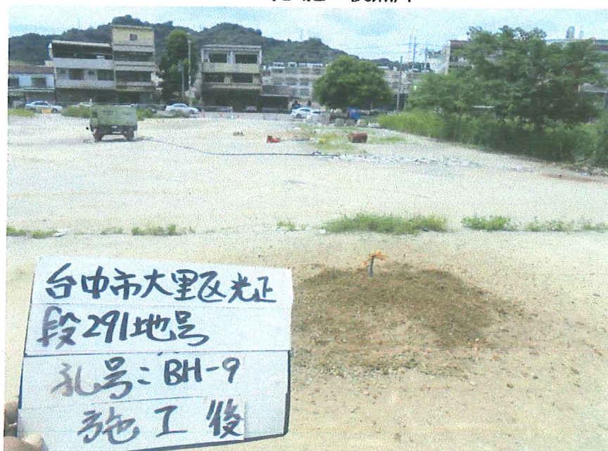
BH-9 孔 施工後照片
