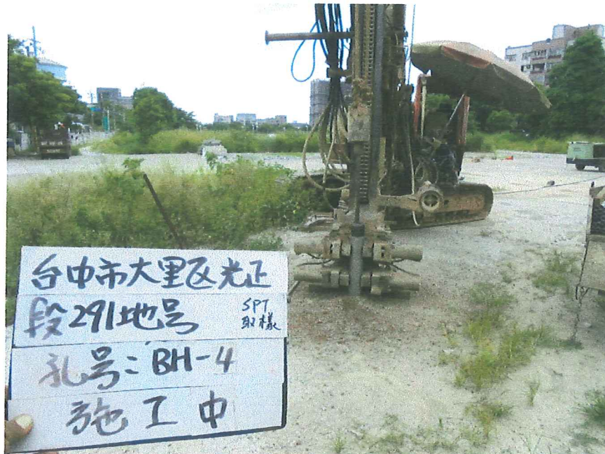
BH-4 孔 施工後照片(取樣劈管)
