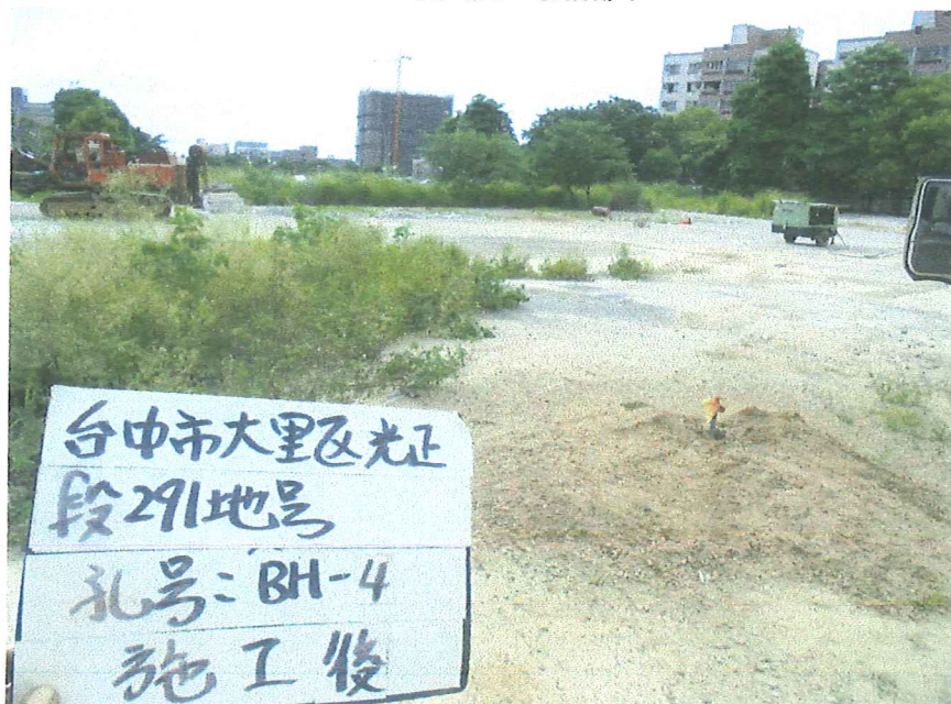
BH-4 孔 施工後照片
