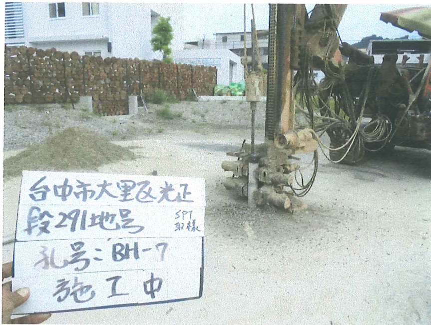
BH-7 孔 施工後照片(取樣劈管)
