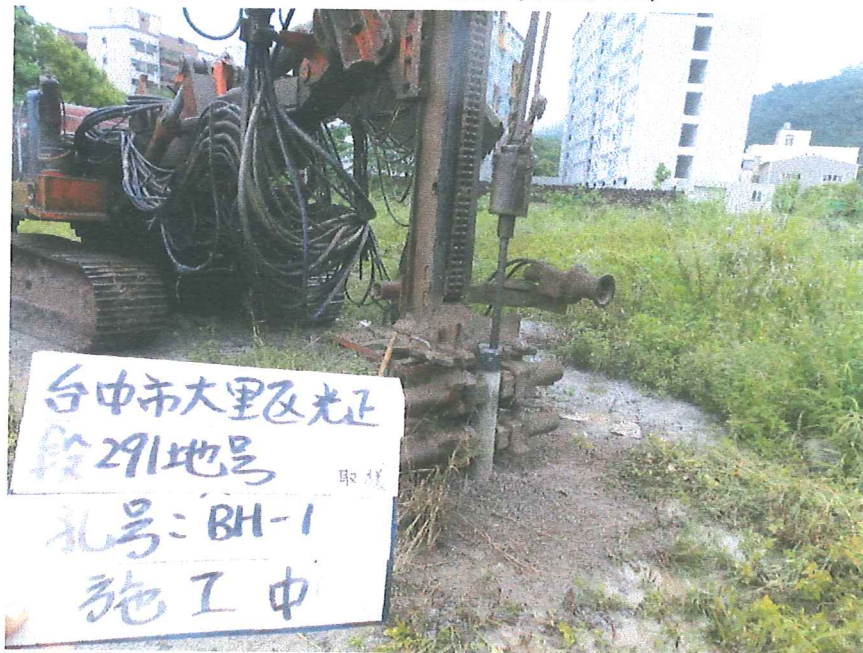
BH-1 孔 施工後照片(取樣劈管)
