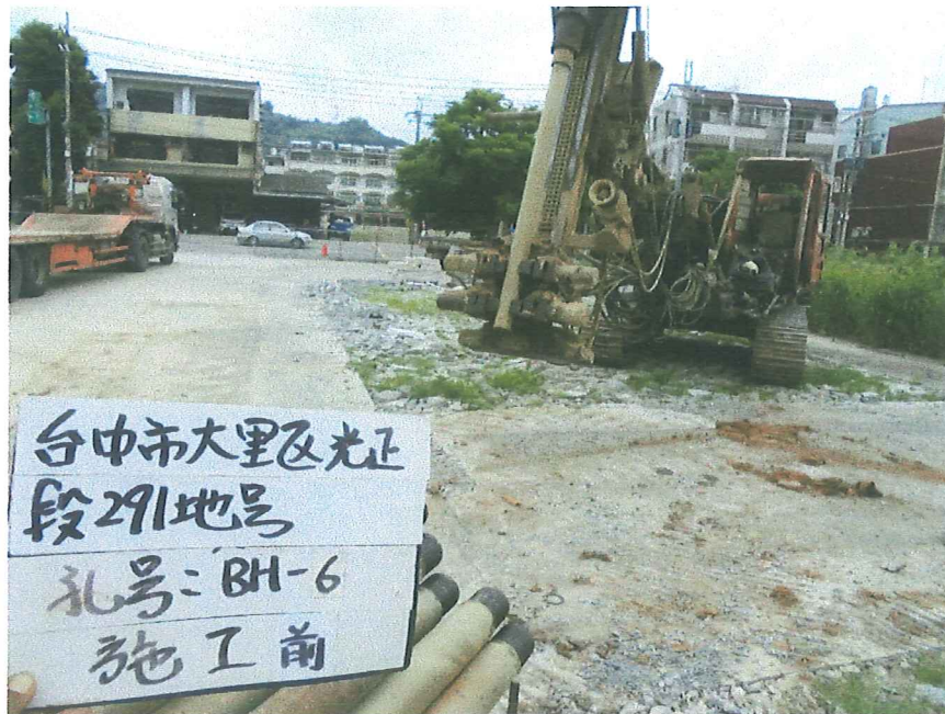
BH-6 孔 施工前照片
