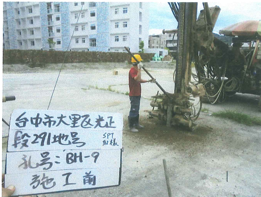
BH-9 孔 施工中照片(取樣劈管)
