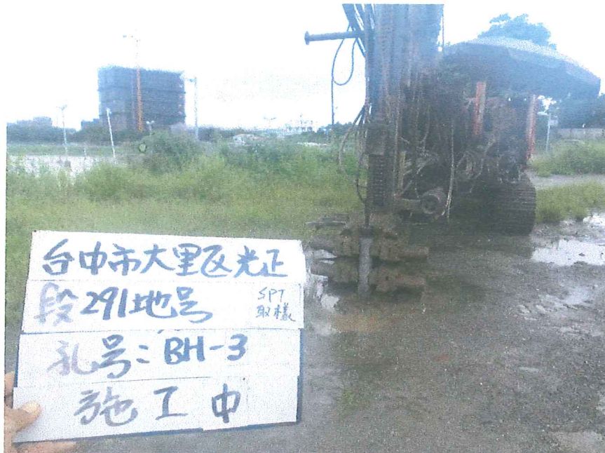
BH-3 孔 施工後照片(取樣劈管)
