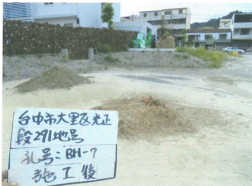
BH-7 孔 施工後照片
