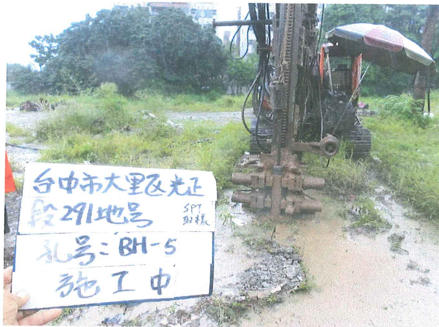
BH-5 孔 施工後照片(取樣劈管)
