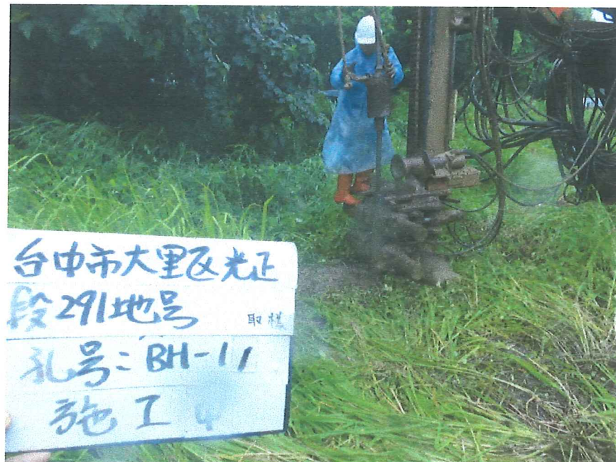
BH-11 孔 施工後照片(取樣劈管)
