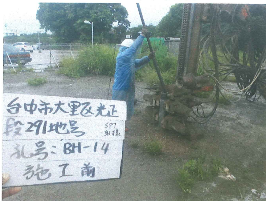
BH-14 孔 施工中照片(取樣劈管)
