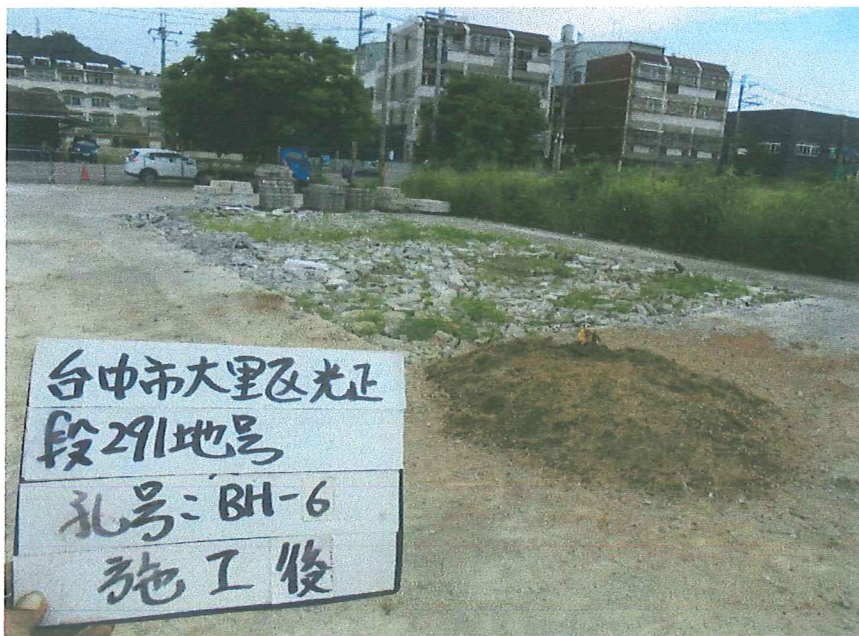
BH-6 孔 施工後照片
