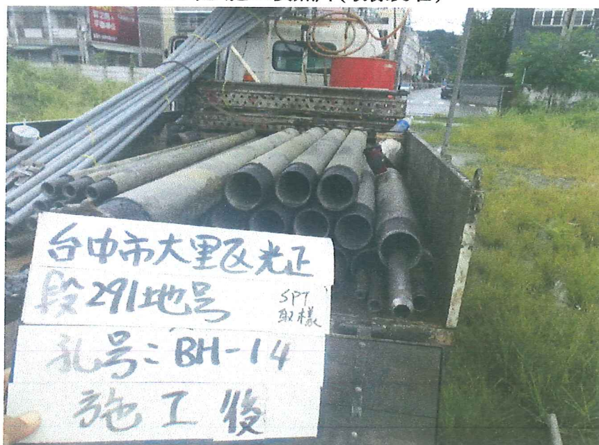
BH-14 孔 施工後照片(取樣劈管)
