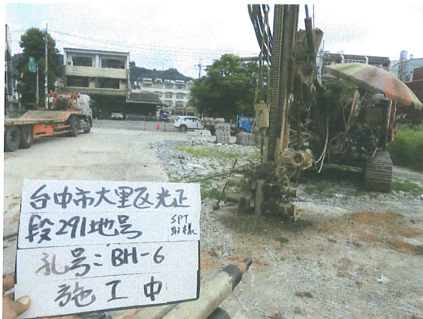
BH-6 孔 施工後照片(取樣劈管)
