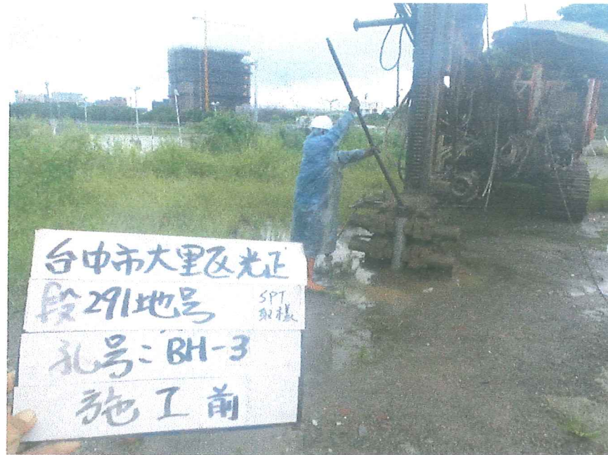
BH-3 孔 施工中照片(取樣劈管)
