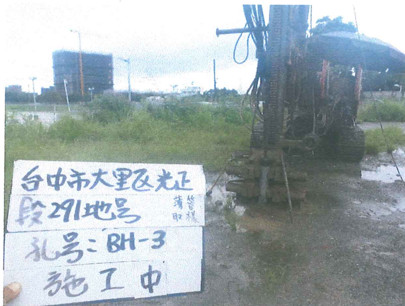
BH-3 孔 施工後照片(取樣薄管)
