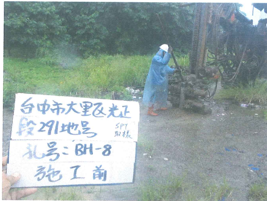
BH-8 孔 施工中照片(取樣劈管)
