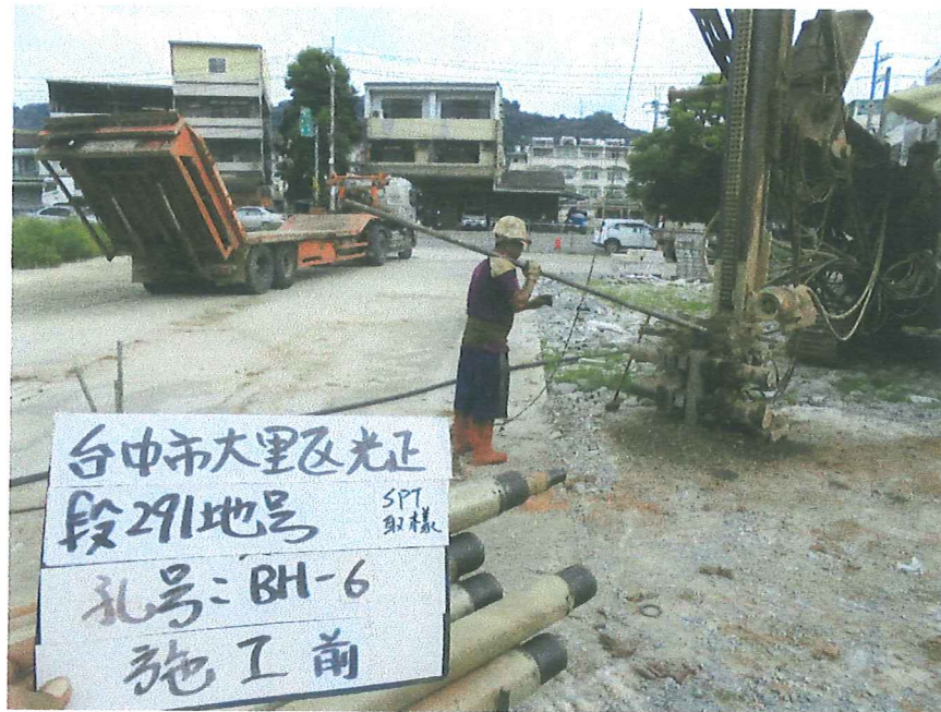
BH-6 孔 施工中照片(取樣劈管)
