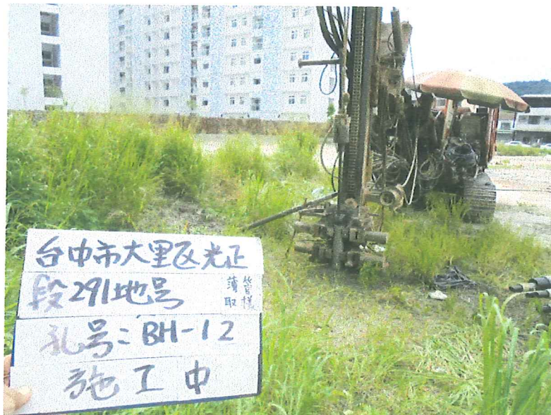
BH-12 孔 施工後照片(取樣薄管)
