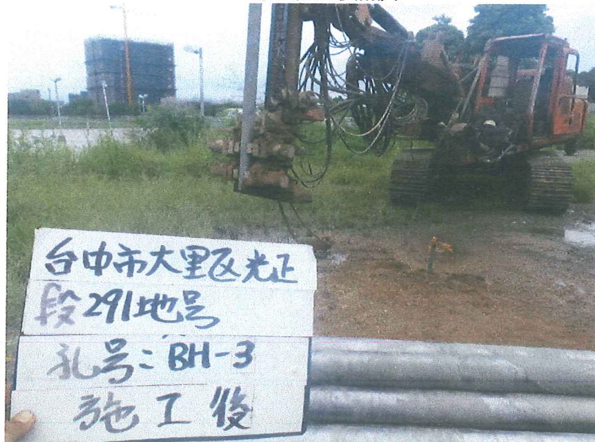
BH-3 孔 施工後照片
