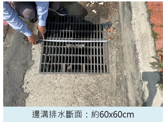
圖 2.5-1 排水設施量測與水路調查圖
