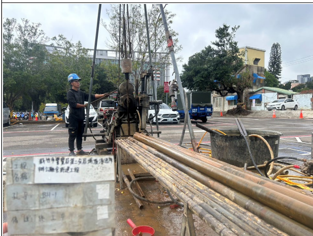
BH-1 鑽孔(施工中)
