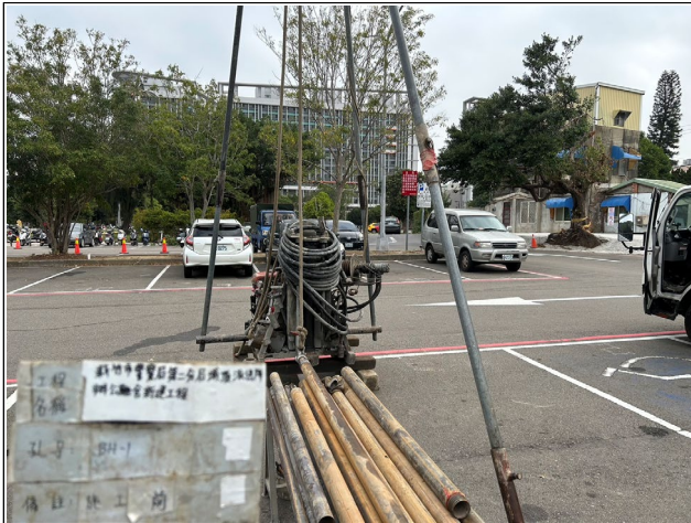
BH-1 鑽孔(施工前)
