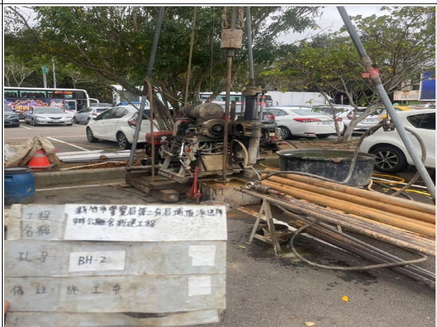
BH-2 鑽孔(施工中)
