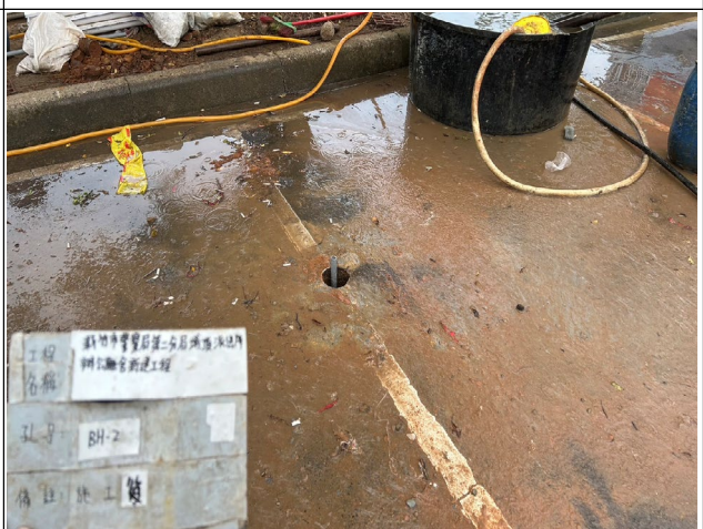
BH-2 鑽孔(施工後)
