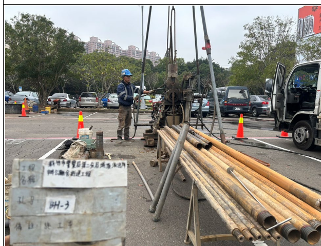
BH-3 鑽孔(施工中)
