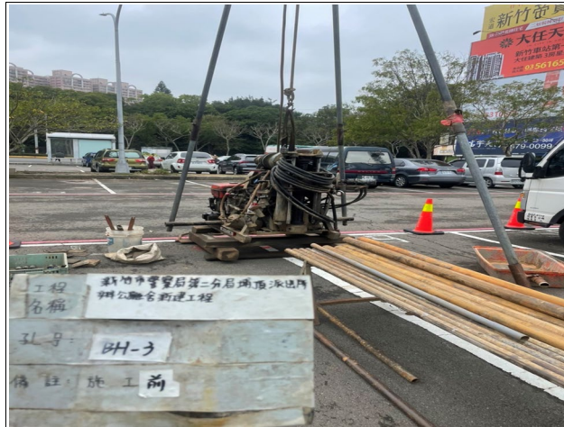
BH-3 鑽孔(施工前)
