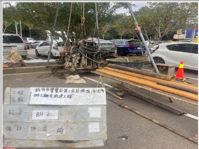
BH-2 鑽孔(施工前)
