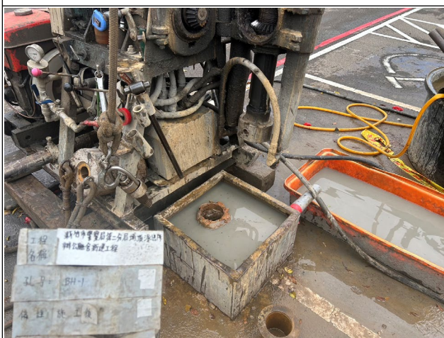
BH-1 鑽孔(施工後)
