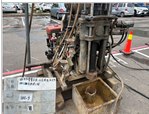
BH-3 鑽孔(施工後)
